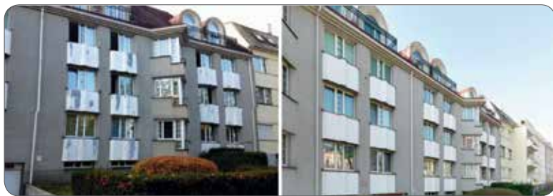
Vorher – nachher: Eine Wohnhausanlage in der Hietzinger Straße vor und nach der Fassadenveredelung mit Folien.
