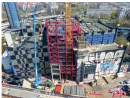
Die Züblin BaugesmbH ist maßgeblich an den Umbauarbeiten an der Müllverbrennungsanlage Spittelau beteiligt.
