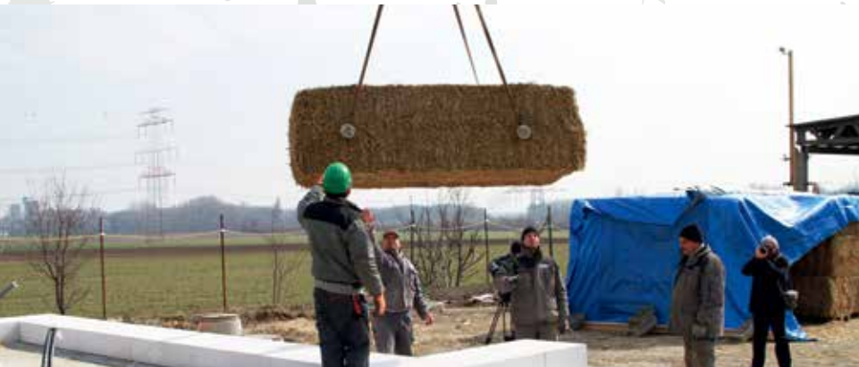
Baumeister Jürgen Höller legt in Ebergassing den Grundstein für das erste lasttragende Strohballen-Musterhaus Österreichs.
