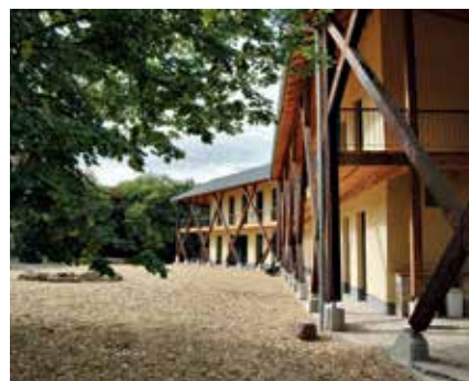
Auf der Burg Ludwigstein in Hessen steht der größte Strohballenbau Deutschlands.
